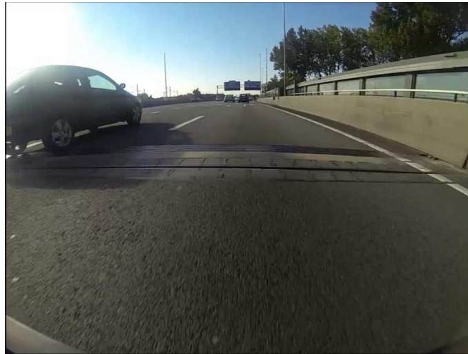
Figuur 6: Foto van de voeg (oostzijde).
